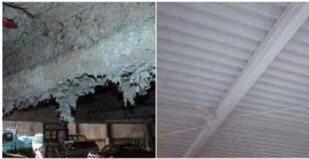
図4 アスベストを含む建材の施工例
